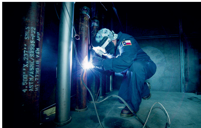
Bild 2. Installation von Temperaturmesstechnik in einer Raffinerie.
